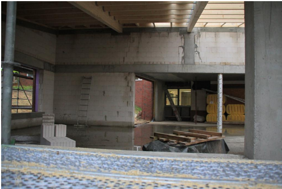
Der Mensa-Rohbau am Hohenwedel
