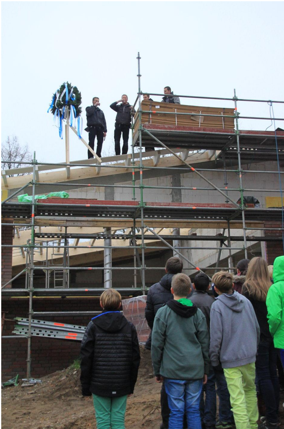
Beim Richtfest stießen die Zimmerleute auf den Neubau an.
